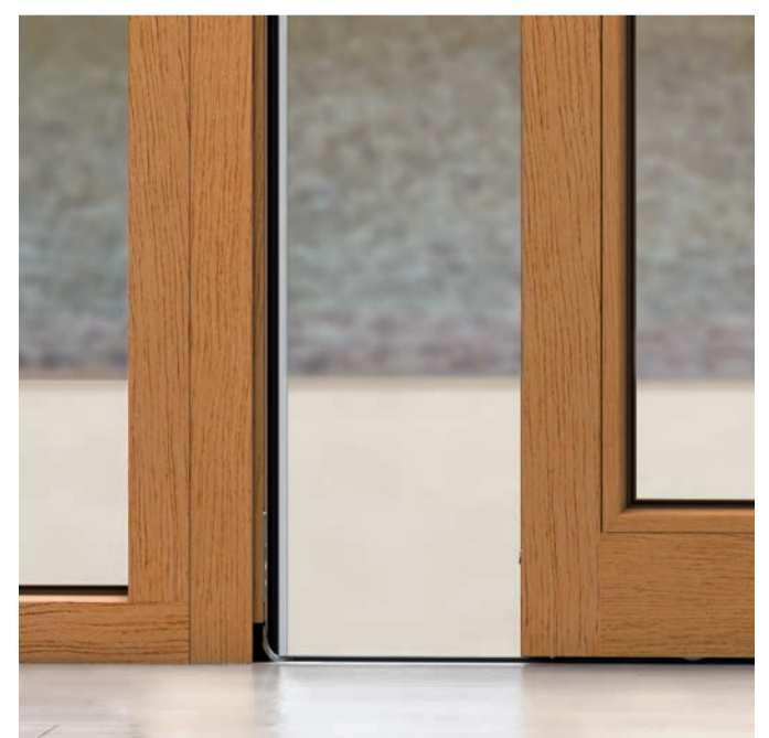
Barrierearm und hochdicht: eine Fenstertür mit Roto Patio Life Schiebe-Beschlag und Komfort-Bodenschwelle
