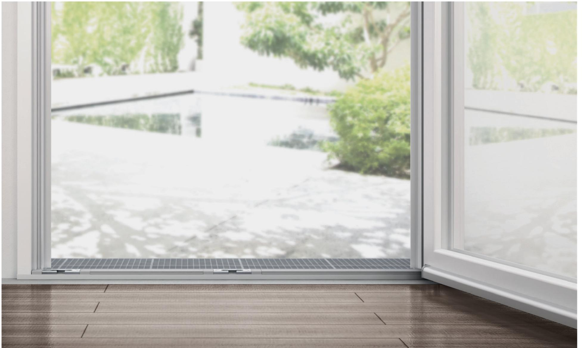
■ **Kunststoff | Holz** Das Programm Roto Eifel umfasst thermisch getrennte Bodenschwellen für ein- und auswärts öffnende Haus-, Balkon- und Terrassentüren aus Kunststoff und Holz. Ein großes Zubehörprogramm macht ihren Einbau sicher, unterstützt hochwertiges Türdesign und steigert den Komfort für den Endnutzer.
