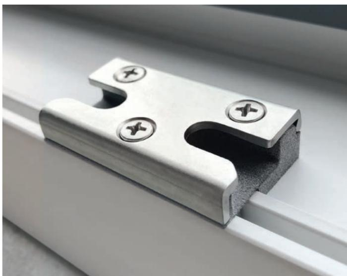
Stahl-Rahmenschließteil mit 3D-gedruckter Kunststoffunterlage für die Anwendung in einem RC 3-fähigen Fenster
