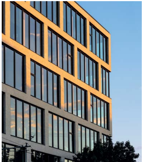
Pro fasádu s velkými prvky z Cascadie se rozhodl i klient „District Office“ v Portlandu v americkém státě Oregon.
