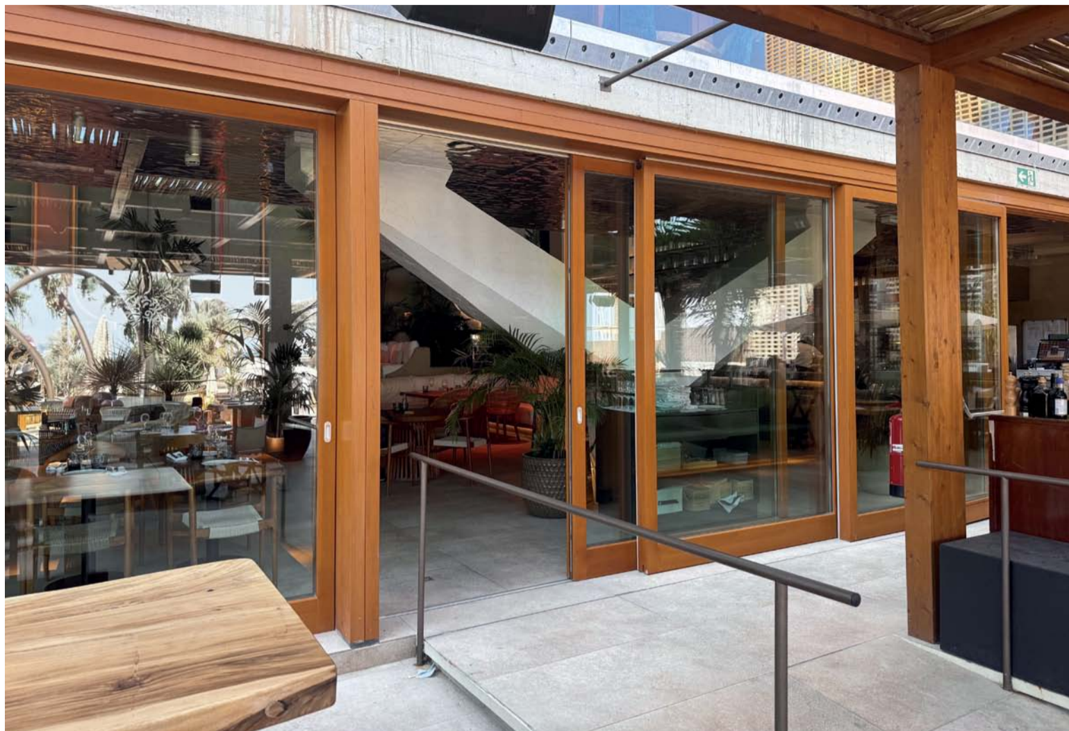
Pro budovu ze 70. let vyrobila společnost Deko Grup-35 přibližně 150 pevných zasklení, otevíravě-sklopných oken a posuvných prvků ze smrkového dřeva. Byly použity profilové systémy ROI Plus 70.2 a 90.3. Všechny obrázky na této stránce: Deko Grup-35 S.L.
