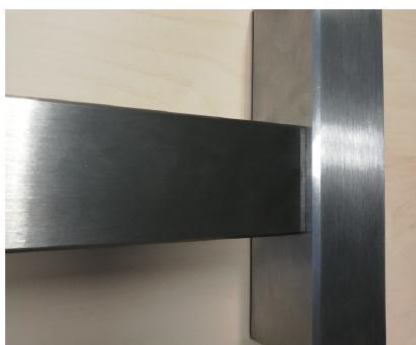
detail napojení vodorovné části
